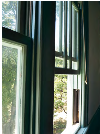
バランスウエイトを内蔵した上げ下げ窓。ガラスも一部は竣工当時のものを使用している
